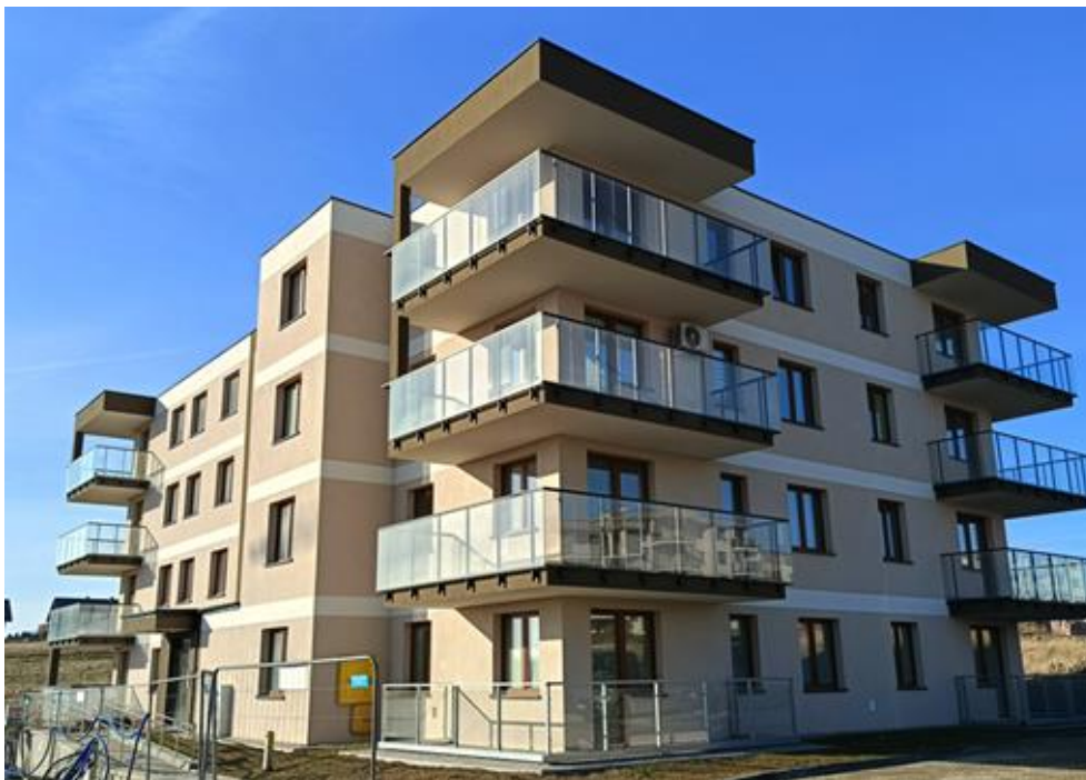
Blok przy ul. Reja 7C
