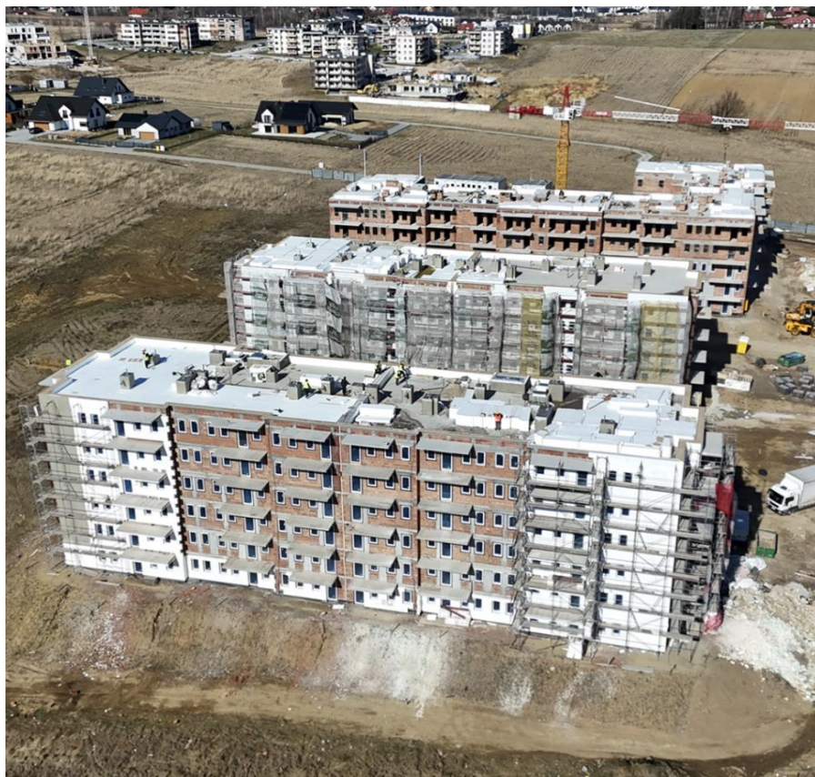
Prace budowlane na osiedlu SIM
