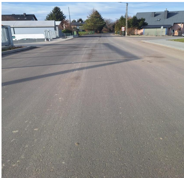
Wyremontowana droga na terenie Gminy Boguchwała
