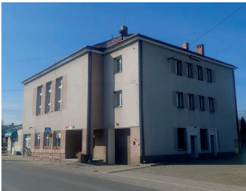
Dom Kultury w Zarzeczcu – stan przed realizacją inwestycji
