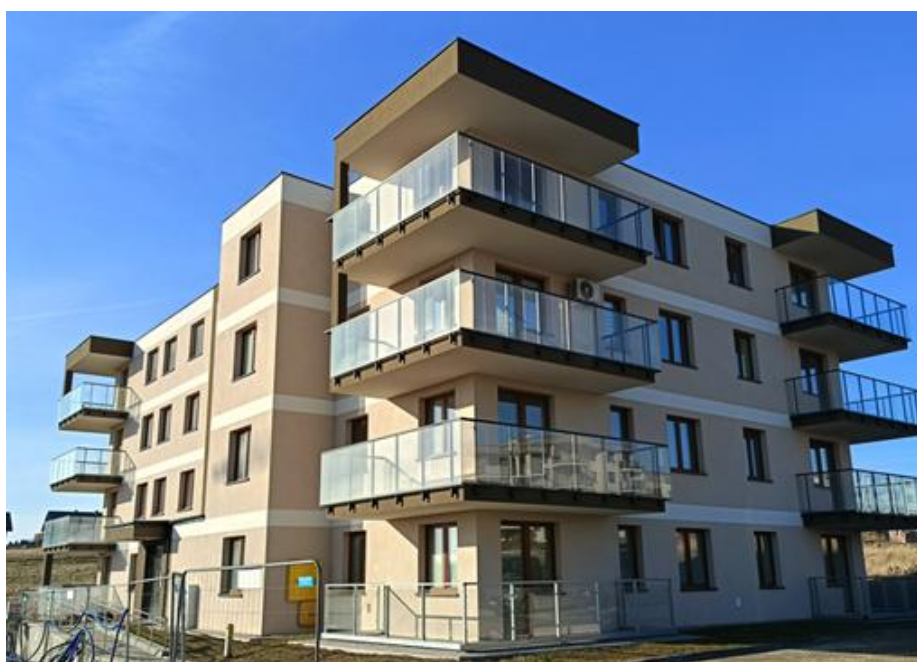
Blok przy ul. Reja 7
