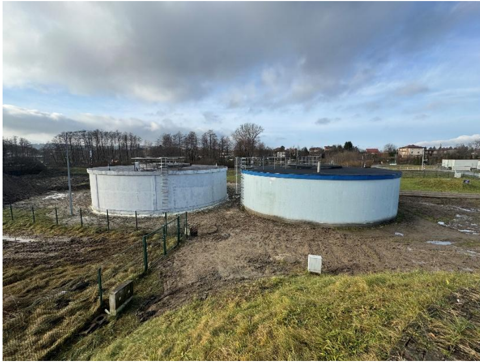
Zbiorniki wody pitnej w Lutoryżu
