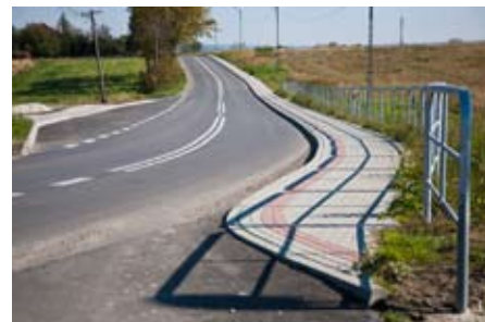
Droga powiatowa Boguchwała-Niechobrz
