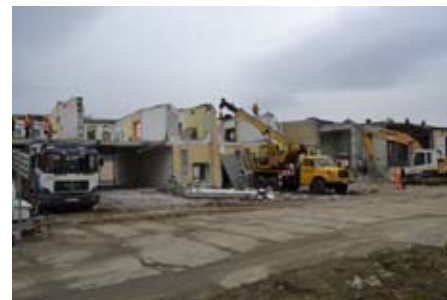
Budowa miejskiego rynku - Boguchwała
